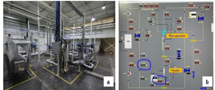
चित्र A.2.20: ए) ईएचसीएल प्रणाली का फोटोग्राफ बी) 300°C, 80 बार की स्थितियों पर ईएचसीएल के गर्म परीक्षण के परिणाम
