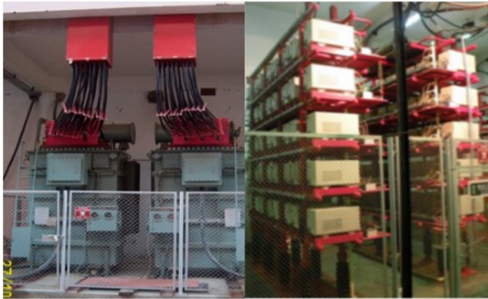
चित्र A.6.4: बहु-सेकेंडरी ट्रांसफॉर्मर (MST) और स्विचिंग पावर मॉड्यूल (SPM) के फोटोग्राफ
