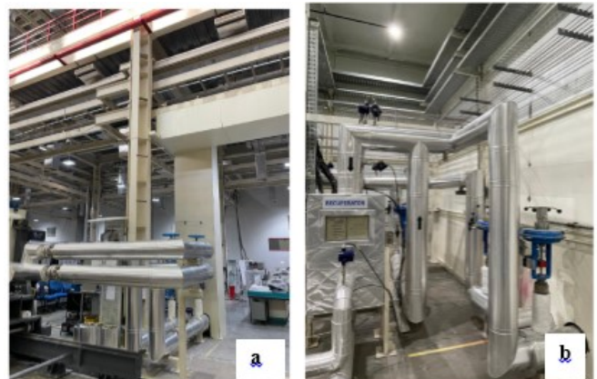
चित्र A.2.21: आपस में जोड़ने वाली पाइपिंग प्रणाली की वास्तविक साइट तस्वीरें ए) HHFTF पर समाप्ति बी) EHCL से पाइपों का उद्गम
