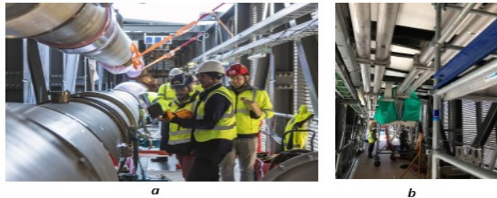
चित्र B.1.11: ITER साइट पर स्थापित क्रायोलाइन।
